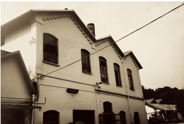
lo stabilimento prima della ristrutturazione foto archivio Delsignore
